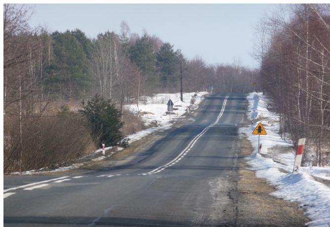
Droga wojewódzka w Jeziórku do remontu. ???
