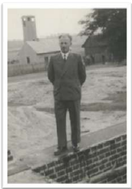
Fot. Na fundamentach wznoszonej Szkoły Tysiąclatki w Krawcach.
