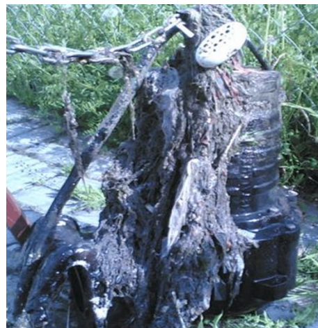
przepompownia ścieków – zatkana pompa, widoczne na pompie szmaty, kostka z WC
