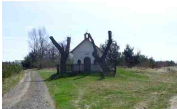
Kapliczka w czasie remontu /zdjęcie z 2010 r.
