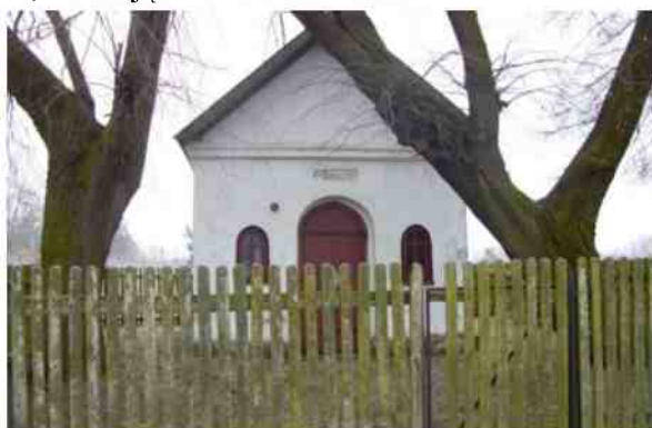
Kapliczka przed remontem/zdjęcie z 2008 r.
