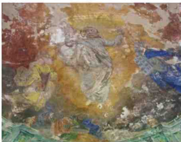
Freski na sklepieniu przed konserwacją/zdjęcie z2008r.
