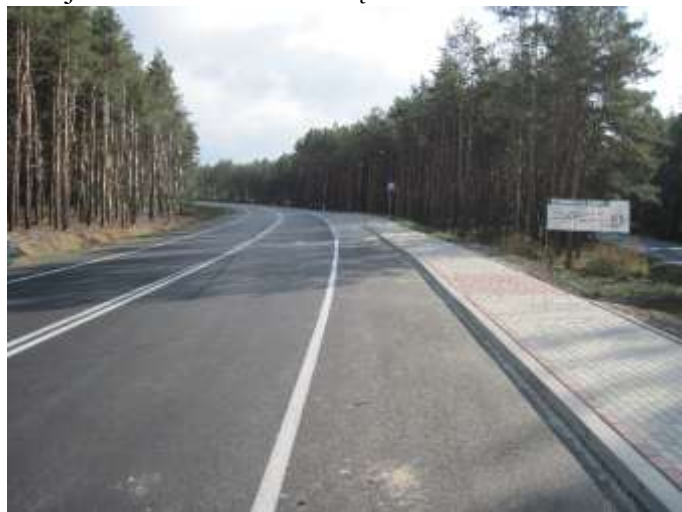
Fot. Nowo otwarta obwodnica Grębowa.
