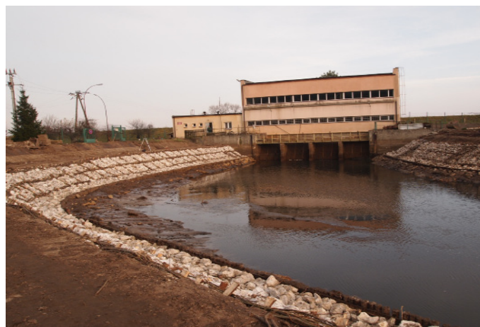
Fot. Odmulenie zbiornika, ubezpieczenie skarp z narzutem kamiennym w koszach podpartych palisadą przy rzece Łęg
