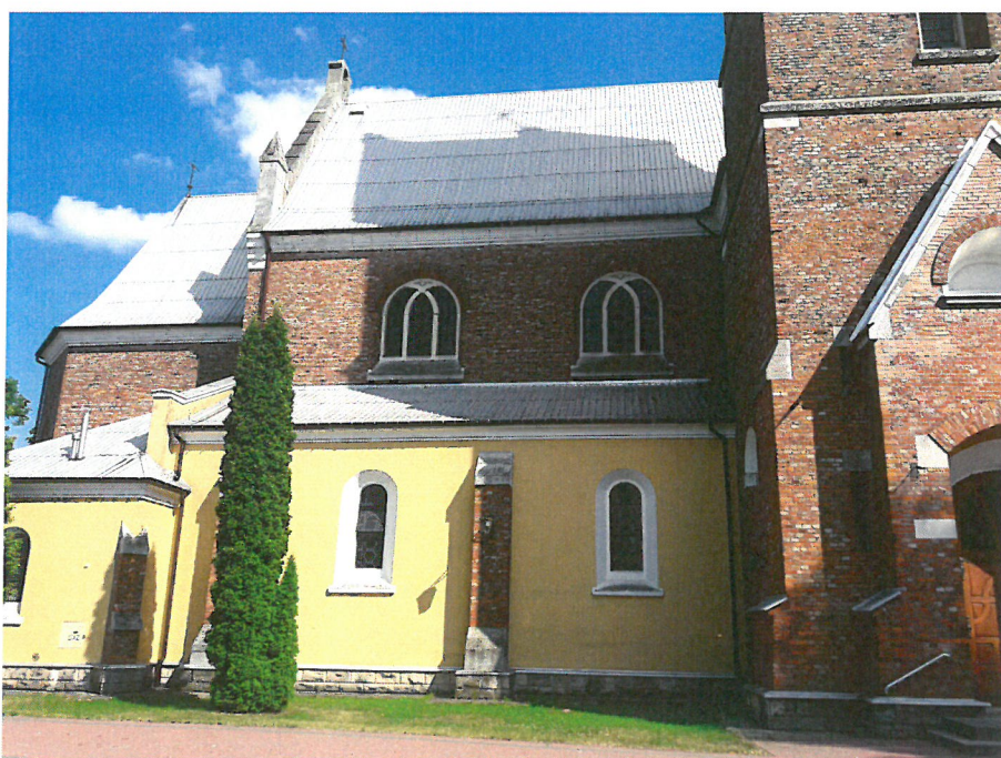
Fot. 1 Istniejący kościół – elewacja.
