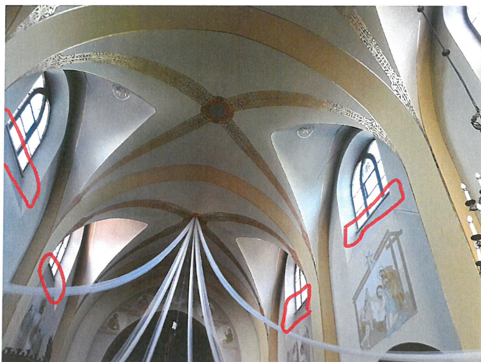
Fot. 2 Rynienki do uszczelnienia.
