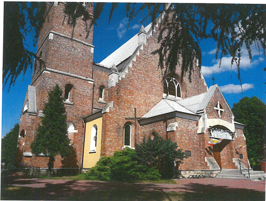
Fot.1 Widok elewacji frontowej kościoła (północno-zachodniej)
