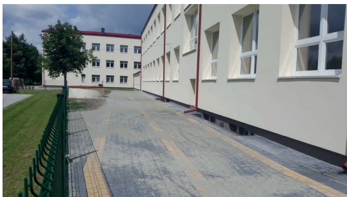
„Budowa chodnika przy ZSO w Grębowie”
