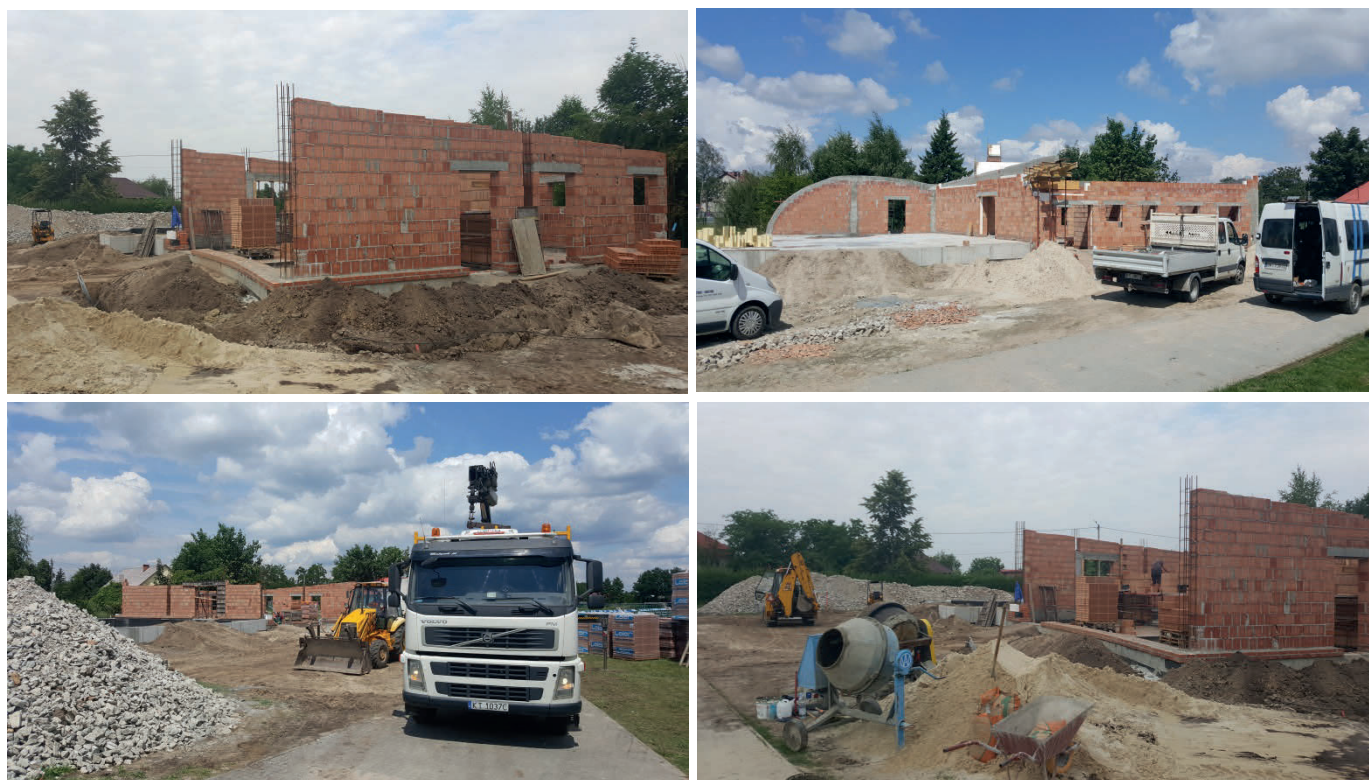
„Budowa małego amfiteatru wraz z zapleczem w Grębowie”
