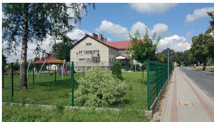
„Przebudowa ogrodzenia Przedszkola w Grębowie”
