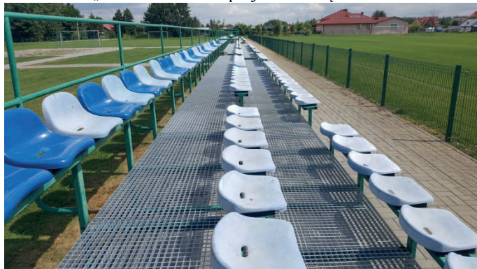
„Remont trybun na stadionie LZS w Grębowie”
