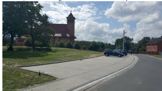
„Utwardzenie terenu przy drodze gminnej Krawce-Kędzie”
