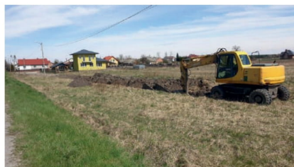
Prace przy kanalizacji w Zabrnju
