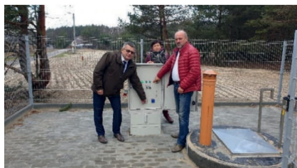
Odbiór kanalizacji w Porębach Furmańskich
