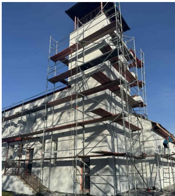
Prace nad wykonaniem elewacji na wieży strażackiej
