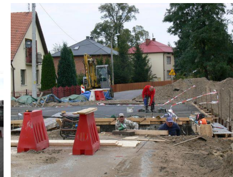
Przebudowa drogi Furmany - Żupawa - Stale
