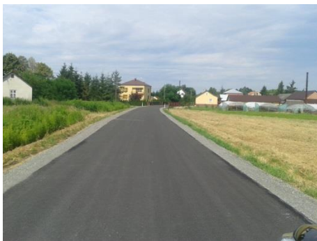
Droga gminna Grębów - Sokół
