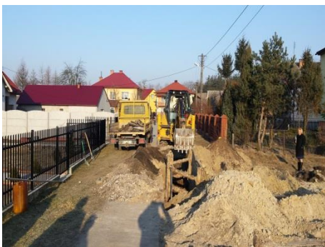
Budowa kanalizacji w Żupawie
